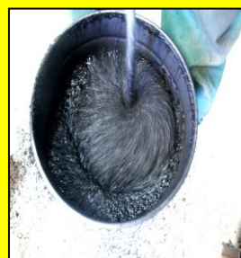
Malaxage du mélange à l'aide d'une perceuse à hélice .
