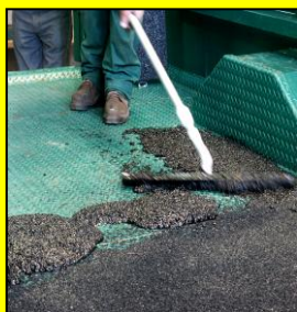
Egalisation du mélange sur le support à l'aide d'une raclette ou spatule crantée.
