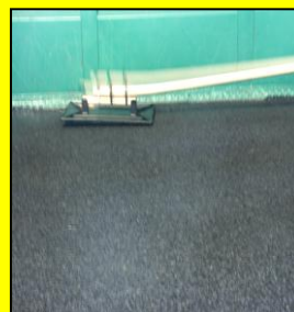
faire pénétrer les grains dans le mélange à l'aide d'une « dame » .
