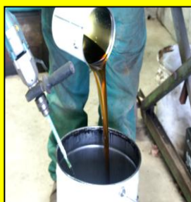
Préparation du mélange résine + durcisseur .
